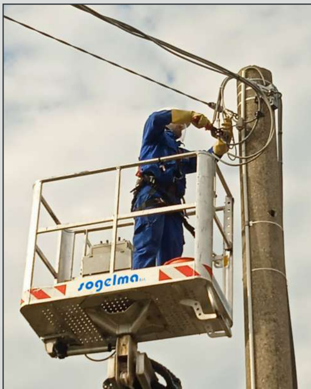
Realizzazione giunti BT
