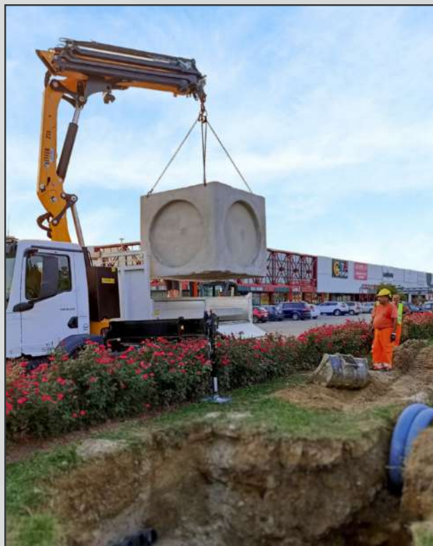
Scavo e posa cameretta
